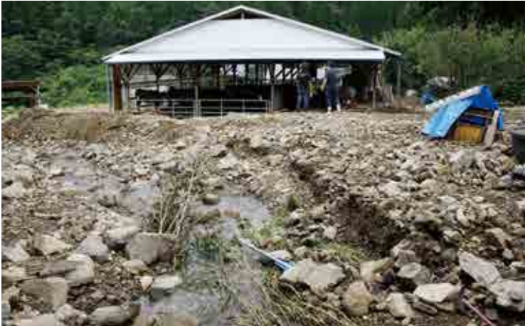
牛舎に大量の土砂が流れ込みました
