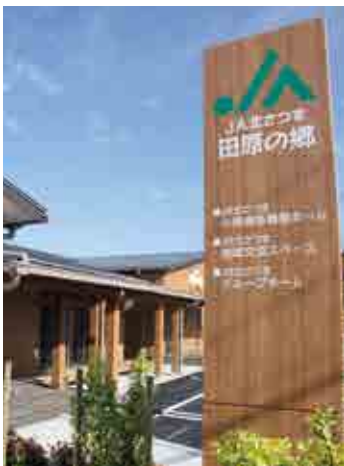
災害発生時に福祉避難所となるJ A福祉施設「田原の郷」
